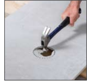
Perforer à l'aide d'une perceuse selon le tracé voulu puis enfoncer avec un marteau.
